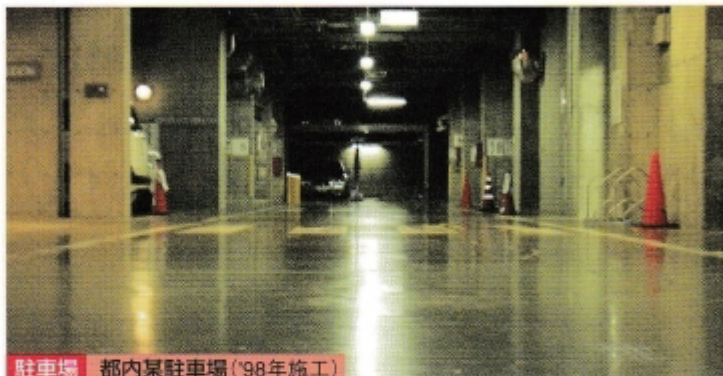
駐車場 都内某駐車場('98年施工)
